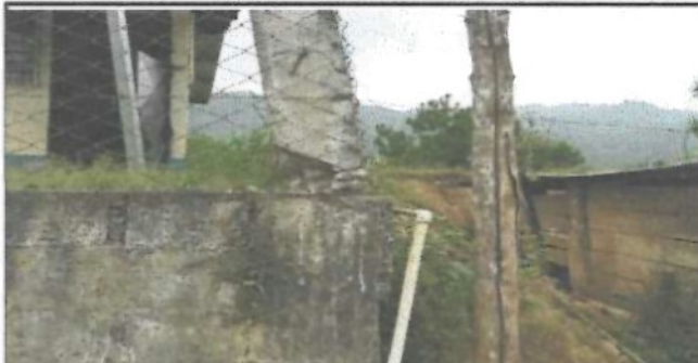
Foto 5: las columnas ya están por caerse, se observa que el muro ya empezó a rajarse.
