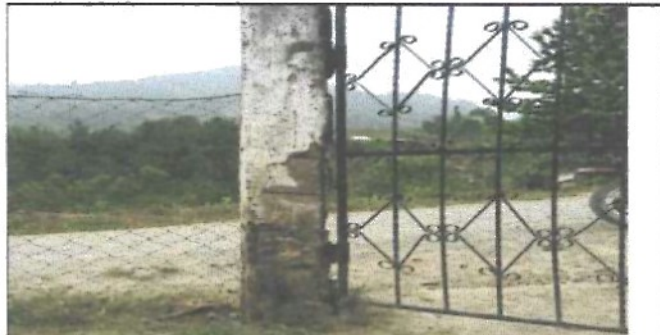
Foto 6: las columnas del portón ya se encuentran deterioradas igualmente el portón ya sufre oxidación.
